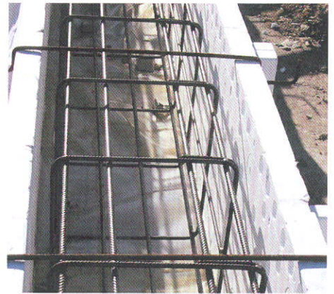
Bekisting en wapening in de funderingsbalk. De PS bekisting dient tegelijkertijd als trillingisolator.
