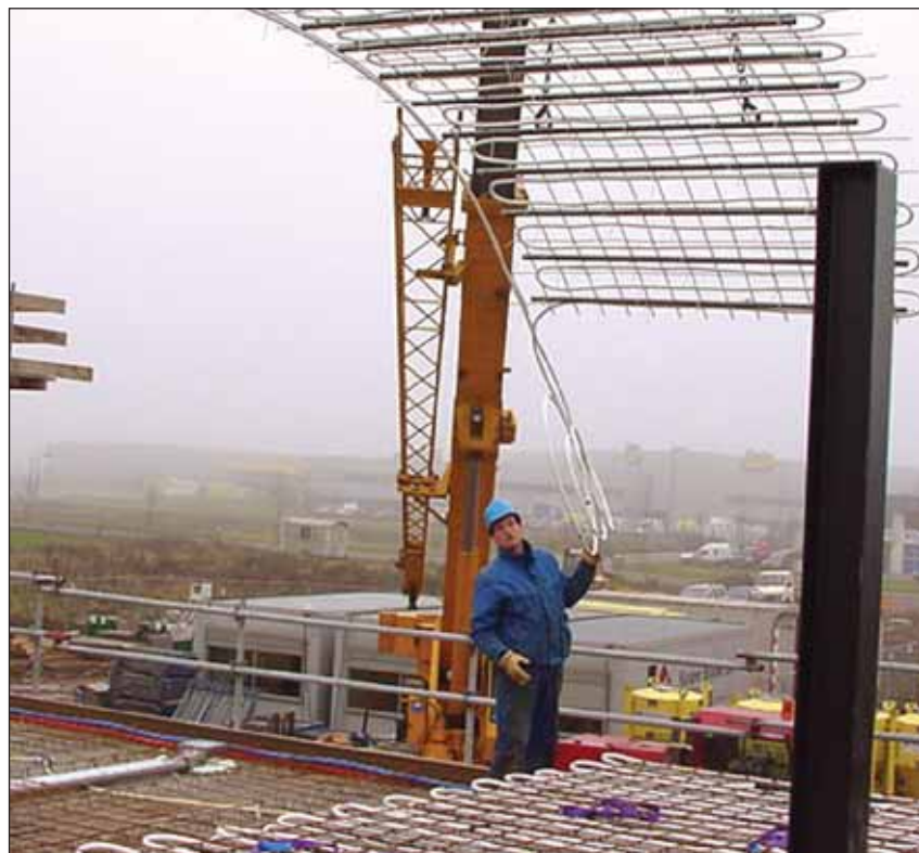
Inhijzen leidingnet in de praktijk (Foto Betonson).
